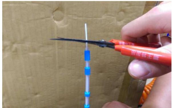
8. Den überstehenden innenliegenden (C) Schlauch bündig mit dem blauen Tornador Schlauch (A) abschneiden. Anschließend die Tülle aufdrehen.
